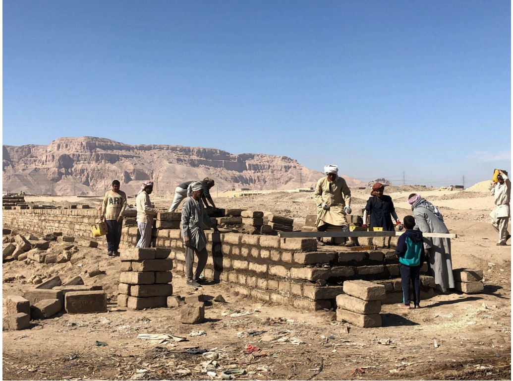
الشكل ١. أعمال الترميم في "القصر الشمالي" والسور المحيط به، للحفاظ على البقايا الأثرية والعمل كحاجز للموقع (تصوير: نيكولاس براون)
